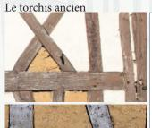
Les vides entre les bois de l'ossature sont remplis par une paroi sans rôle porteur, faite de torchis, mélange de terre argileuse et de fibres végétales.
