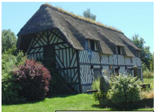
➤ Toiture en Chaume sur Champosoult
