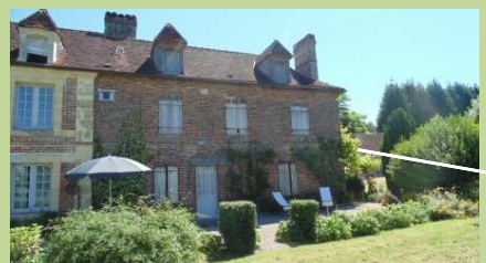
A droite, maison originellement en pans de bois recouverte en brique, à gauche une maison a été rajoutée au XIXe siècle avec un style plus rationnel
