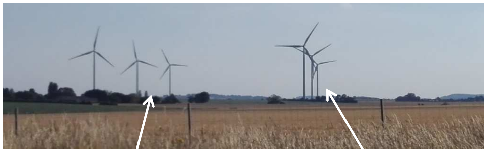
Implantation en décalée – hauteurs qui semblent similaires – un nombre limité sur une même ligne
