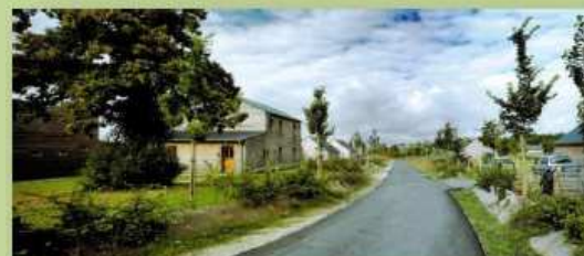
Exemple de traitement sobre d'une voie de desserte de logements, en sens unique (3 mètres de large)
